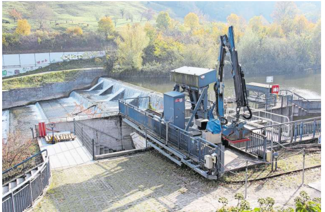
Investition: Die Sicherung des Birswehrs kostet 3,5 Millionen Franken, für die Erneuerung der Fischtreppe beim Kraftwerk investiert das Bundesamt für Umwelt 14 Millionen Franken.
