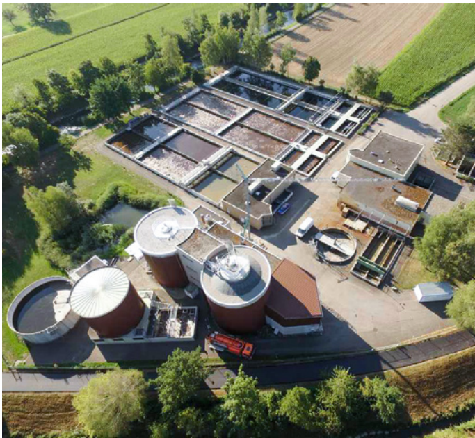
Fig. 3 Luftaufnahme der Kläranlage Niederglatt. Die ARA liess den Schlammstapel im Rahmen des Förderprogramms von South Pole gasdicht abdecken. (Foto: ARA Niederglatt)
