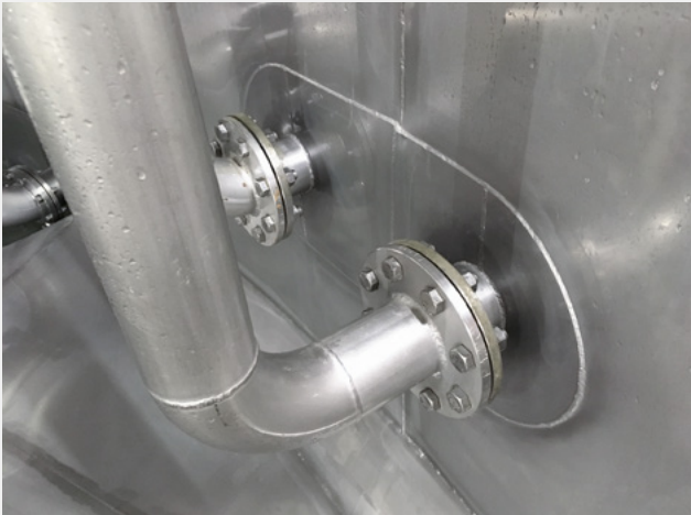
Fig. 5 Die bestehenden Quelleinlaufleitungen wurden mit der neuen Edelstahlauskleidung verschweisst.
