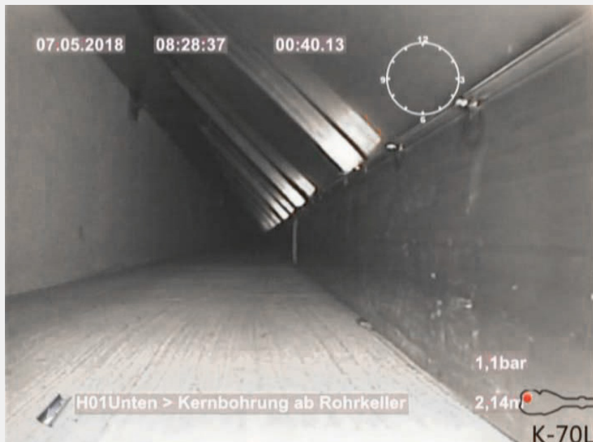
Fig. 9 Kamerabefahrung eines Inspektionskorridors entlang des Wandfusses.
