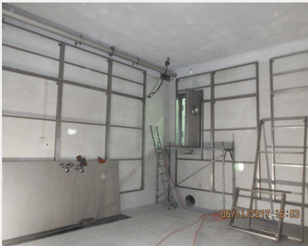
Fig. 2 Reservoir Fluh, Laufen: Erstellung der Unterkonstruktion an den Wänden.
