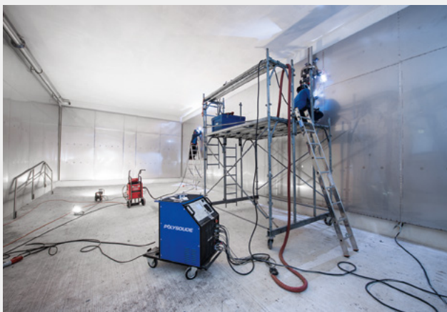
Fig. 3 Reservoir Fluh, Laufen: Verschweissung der Edelstahlbleche an den Wänden.
