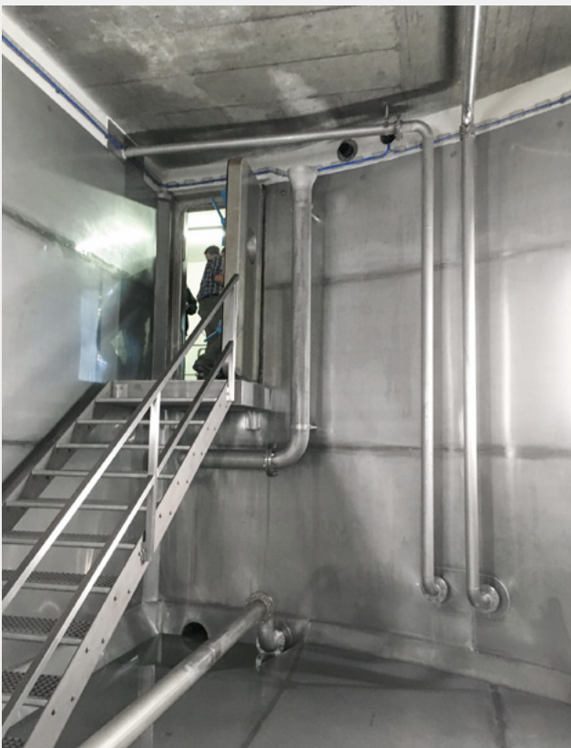
Fig. 6 Reservoir Wahlen: fertiggestellte Edelstahlauskleidung.
