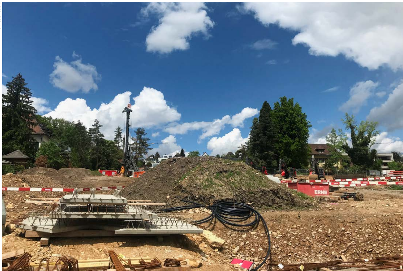
Nach dem fachgerechtem Abtrag des Mutterbodens kann dieser in Trapezform bis zu einer maximalen Höhe von 2,5 Metern direkt auf gewachsenem Boden auf der Baustelle gelagert werden.
